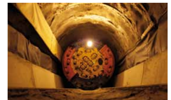
Avancement des travaux de l'interconnexion France-Espagne dans les Pyrénées Orientales – © MOREN Thomas RTE
