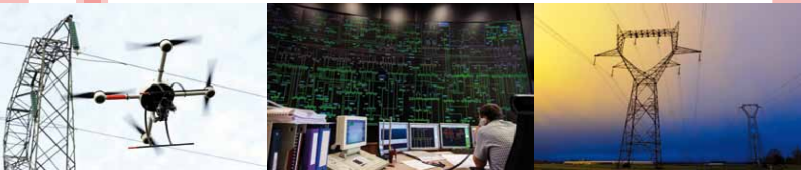
Drone effectuant un survol des pylônes pour repérer leur corrosion - © ROUX Lionel - RTE
