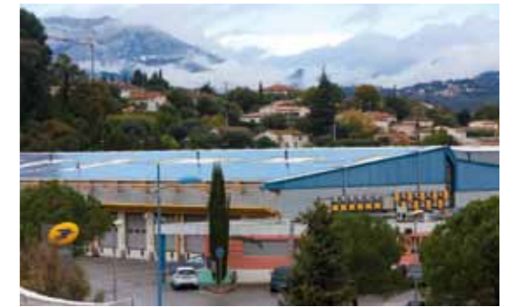
Installations du démonstrateur de quartier solaire intelligent Nice Grid à Carros : bâtiment de la Poste au toit équipé de panneaux photovoltaïques
